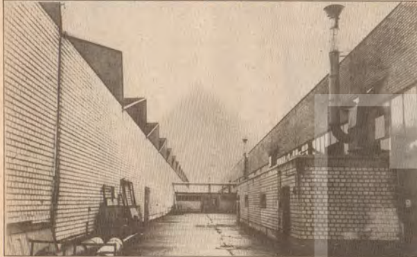
Bad Kreuznach'daki Bretz mobilya fabrikasının dıştan görünüşü.
