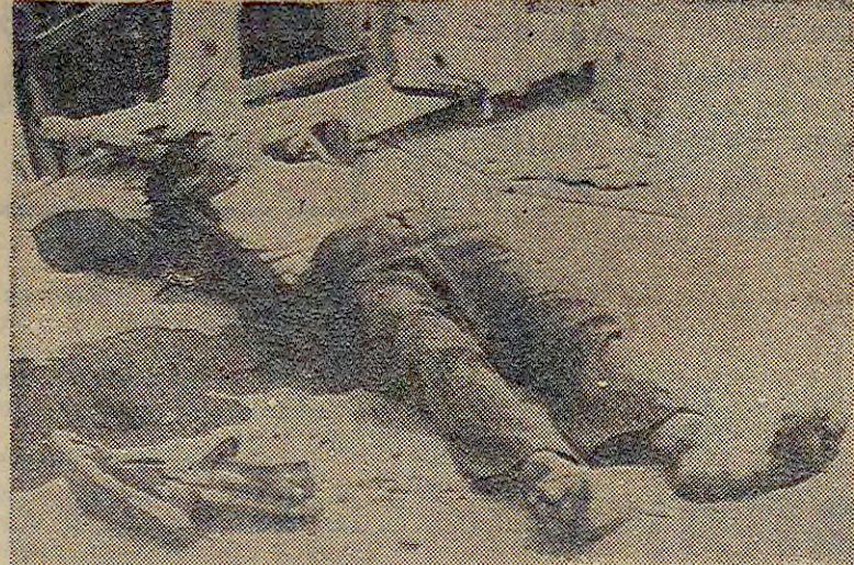
Kocaelide insaatıta demir çıkarırken elektrik çarpması sonucu binadan düşerek ölen işçi Refik Zanta...
