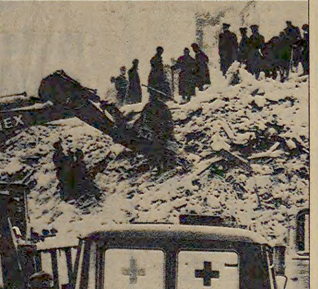
Deprem sırasında yıkılan bir bina... Deprem sırasında yıkılan bir bina...
