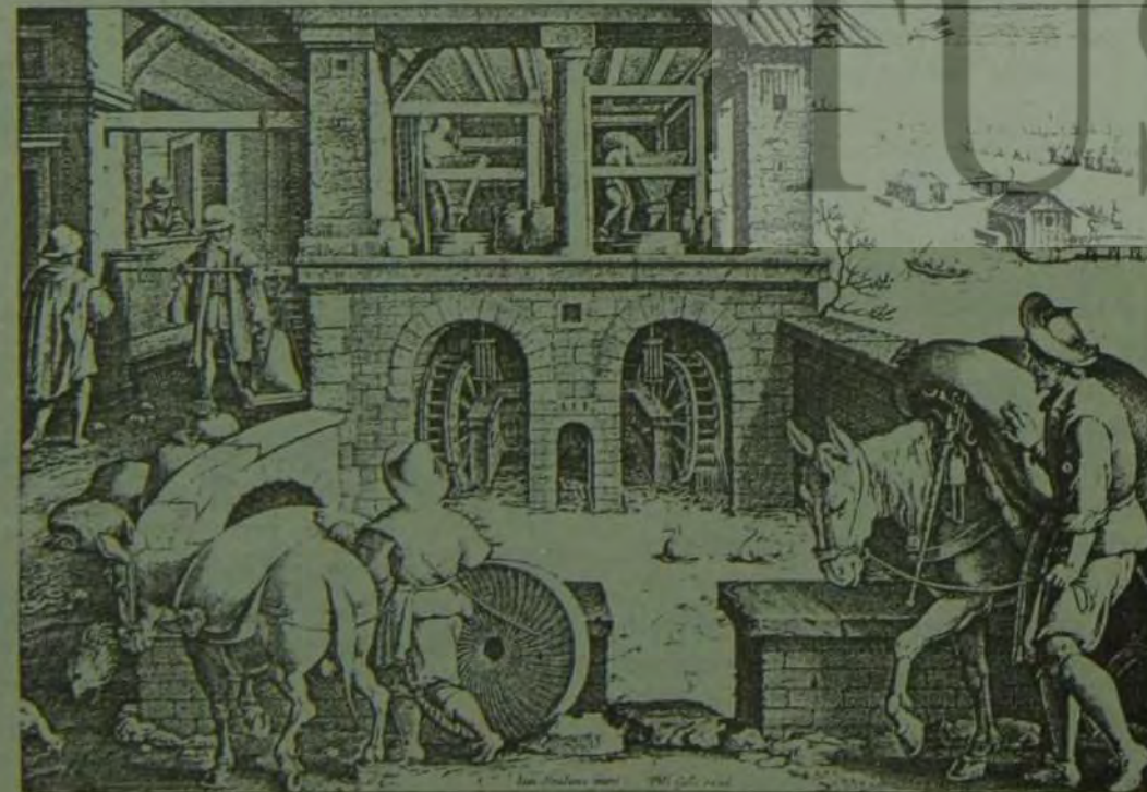
Suyun potansiyel enerjisinden yararlanılması: Ortaçağ su değirmenleri
