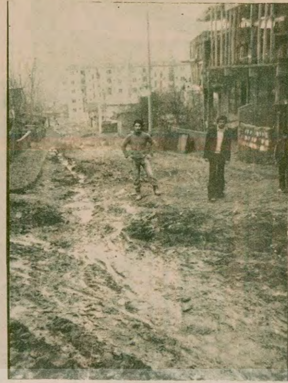
Örnek olacak denilen mahallenin yolları aradan on yıl geçmesine rağmen hala tamamlanmadı. Yurttaşlar bir an önce yolların yapılmasını bekliyor.
