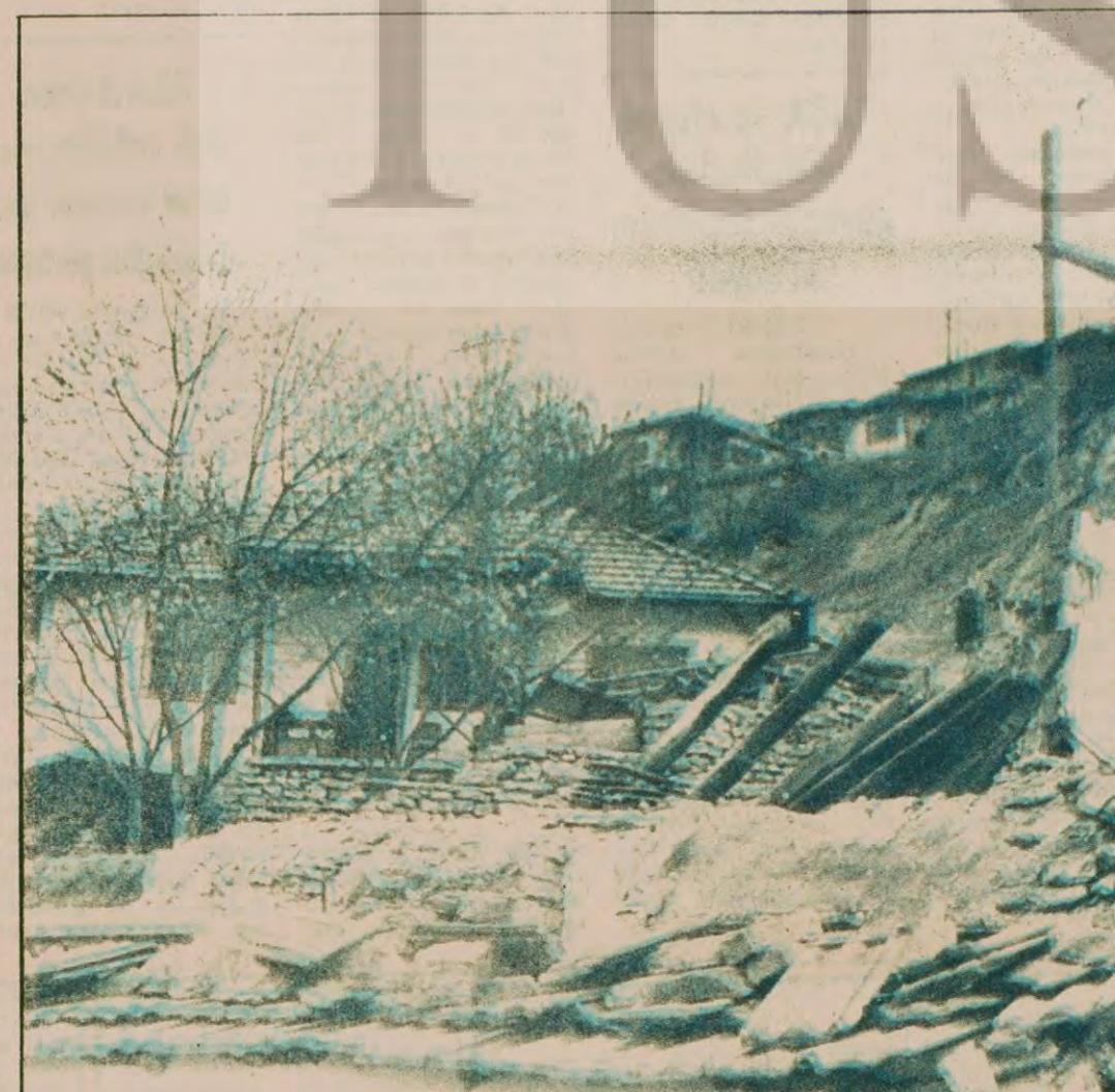
Ankara Şirintepe Dutluk Mahallesinde toprak akşamdan sabaha kayıyor. Elli ev dümdüz, yerle bir oldu...
