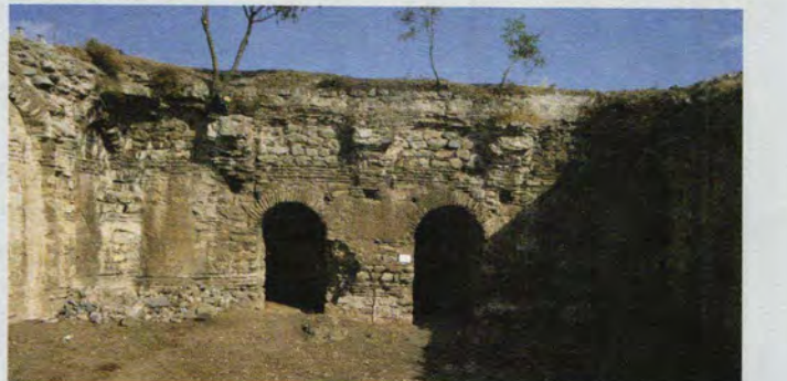
Sarnıcın kubbeli bölümüne girişi sağlayan açıklıklar. Aperture tra la sala cupolata ed il lato ovest della cisterna. (2001)
