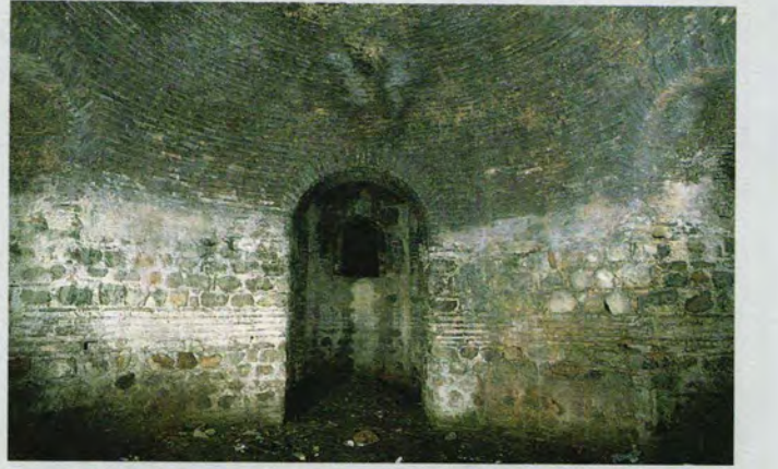
Sarnıcın kubbesi ve su kanalı. / Interno della cisterna, cupola in laterizio. (2002)
