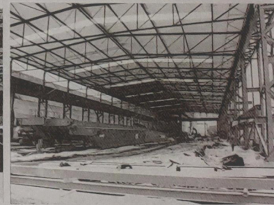
An der Schiffbauhalle 240 ändert sich das innere und äußere Bild ständig. Auf dem Foto links werden die Wandkassetten gesetzt, die Industrieverglasung wird vorgenommen und die Trapezbleche zur Aufnahme der Dämmung und farblichen Außenschale wird montiert.
