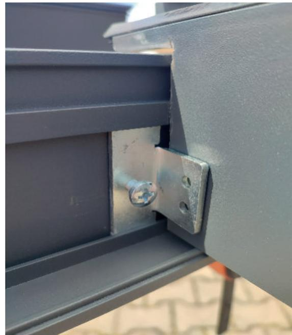
Am Rinnenprofil erfolgt die Befestigung gleich wie am Wandprofil. Somit ist die Möglichkeit gegeben die Dachneigung variabel zwischen 4° und 15° zu wählen
