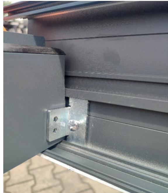
Beim System SAMOA und BALI ist das Wandprofil 10 mm höher und die Befestigung der Träger erfolgt mit Winkelprofile die im Wandprofil eingeschoben werden.
