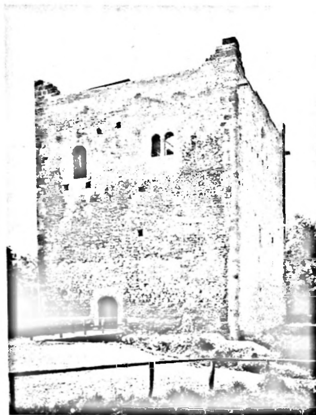
Mittlere Burg nach der Restaurierung 1956
