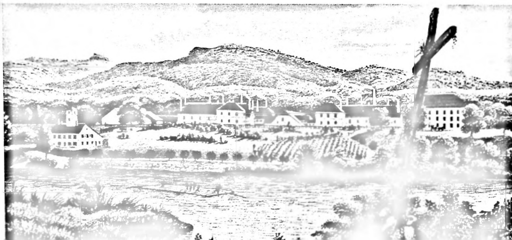
Ansicht der Saline Schweizerhalle aus dem Jahr 1845 vom Nordufer des Rheins aus. Links im Bild die Villa «Glenck» (mit Türmchen) über dem ersten Salzbohrloch, rechts des Kreuzes das Solbad.
