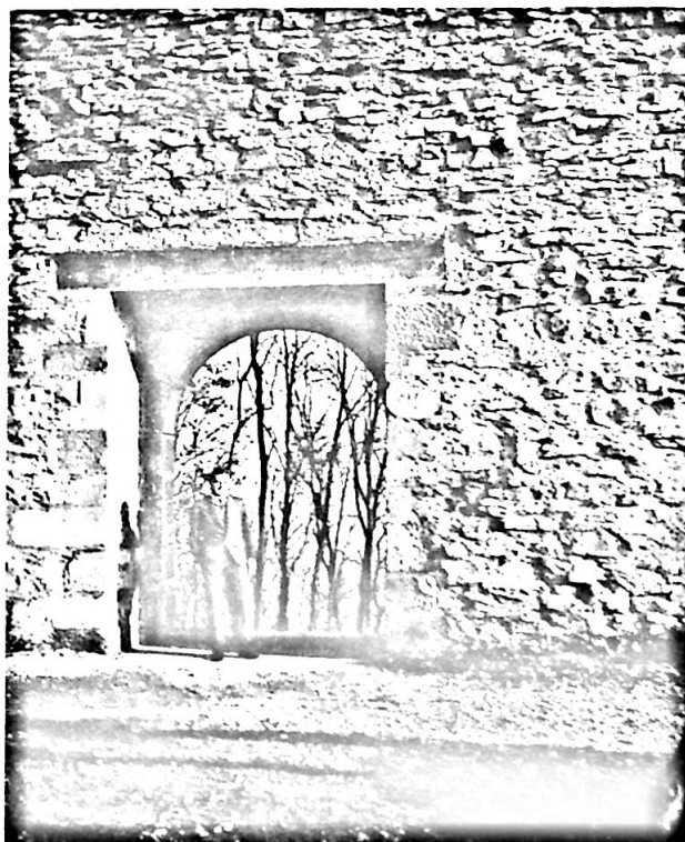
Hintere Burg Eingangstor nach der Restaurierung 1936
