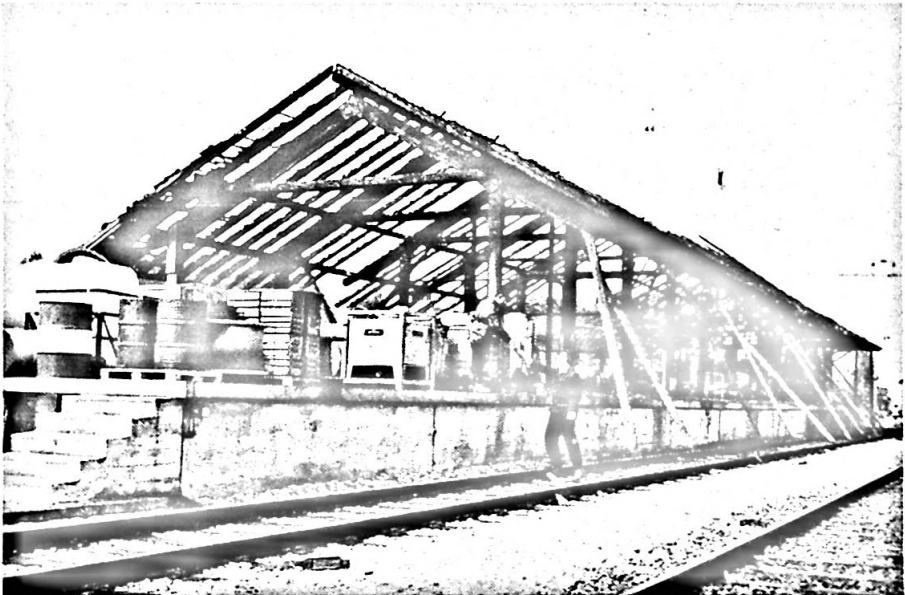
Brand des Güterschuppens SBB, vom September 1971 (Unter freundlicher Genehmigung des ED Baselland)
