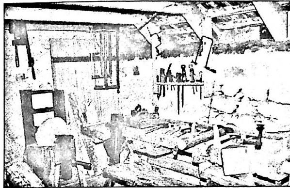
Für Reparaturen gut gerüstet...
