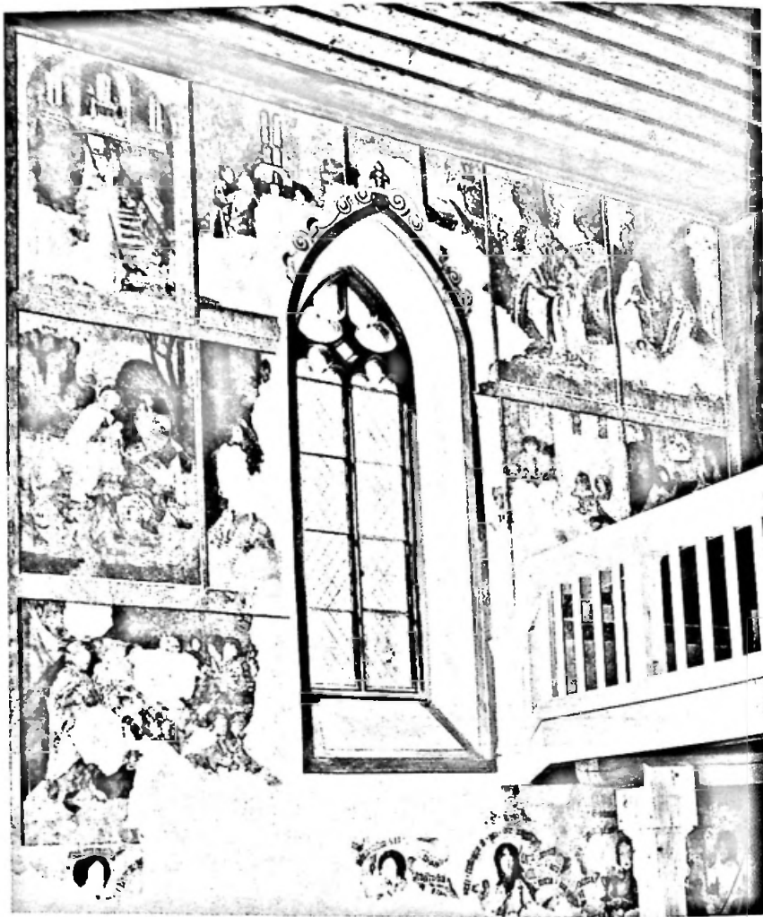
10. Westliche Hälfte der Südwand mit Empore.
