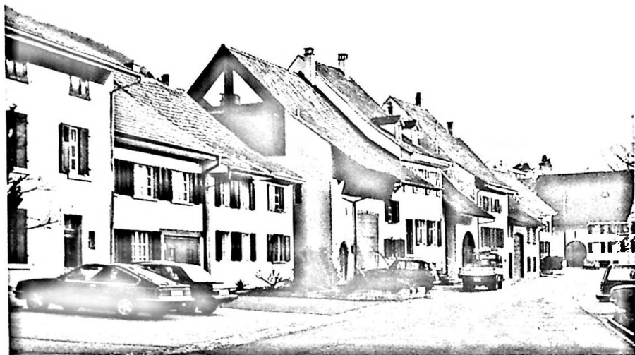
16 Oberdorf, Ansicht der Ostseite
