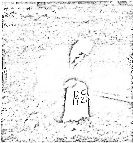
Bild 6a. Stellen des Steines auf die Humusschicht.
