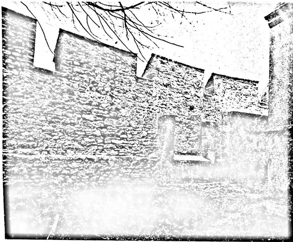
Fig. 4. — Muttenz. Kirche St. Arbogast. Partie der Wehrmauer im Osten mit Mauerrücksprung, senkrechter Bauluge und verschieden hoch aufgemauerten Scharfen.
