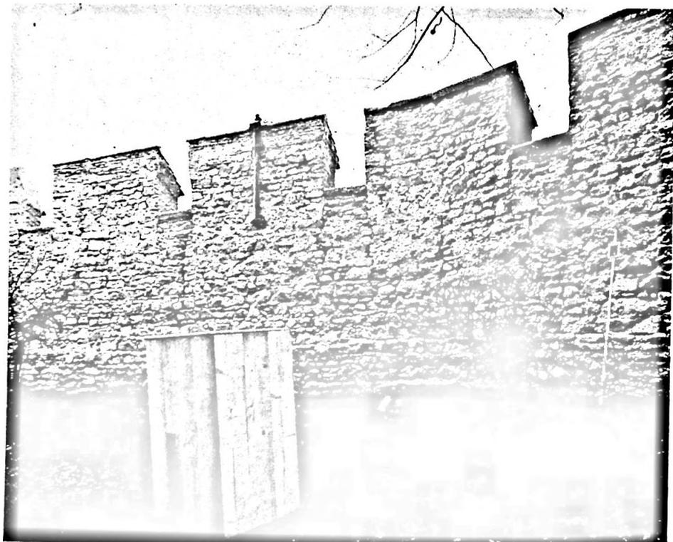
Fig. 5. — Muttenz. Kirche St. Arbogast. Partie der Wehrmauer im Westen mit teilweise zugemauerten bzw. erhöhten Scharfen. An der Mauertechnik (unterer Teil Wechsel von schmalen/breiten Steiniagen) sind zwei Bauperioden zu unterscheiden.
