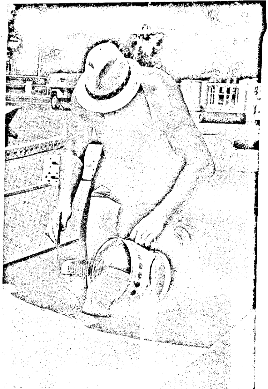
Wie ein Teppich wird die Laufbahn verlegt.
