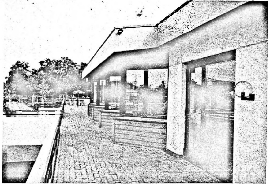
Die Nordseite des Garderobengebäudes mit Eingang zum Clubrestaurant.
