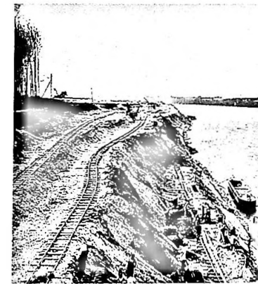
A droite: construction du port en 1938.
