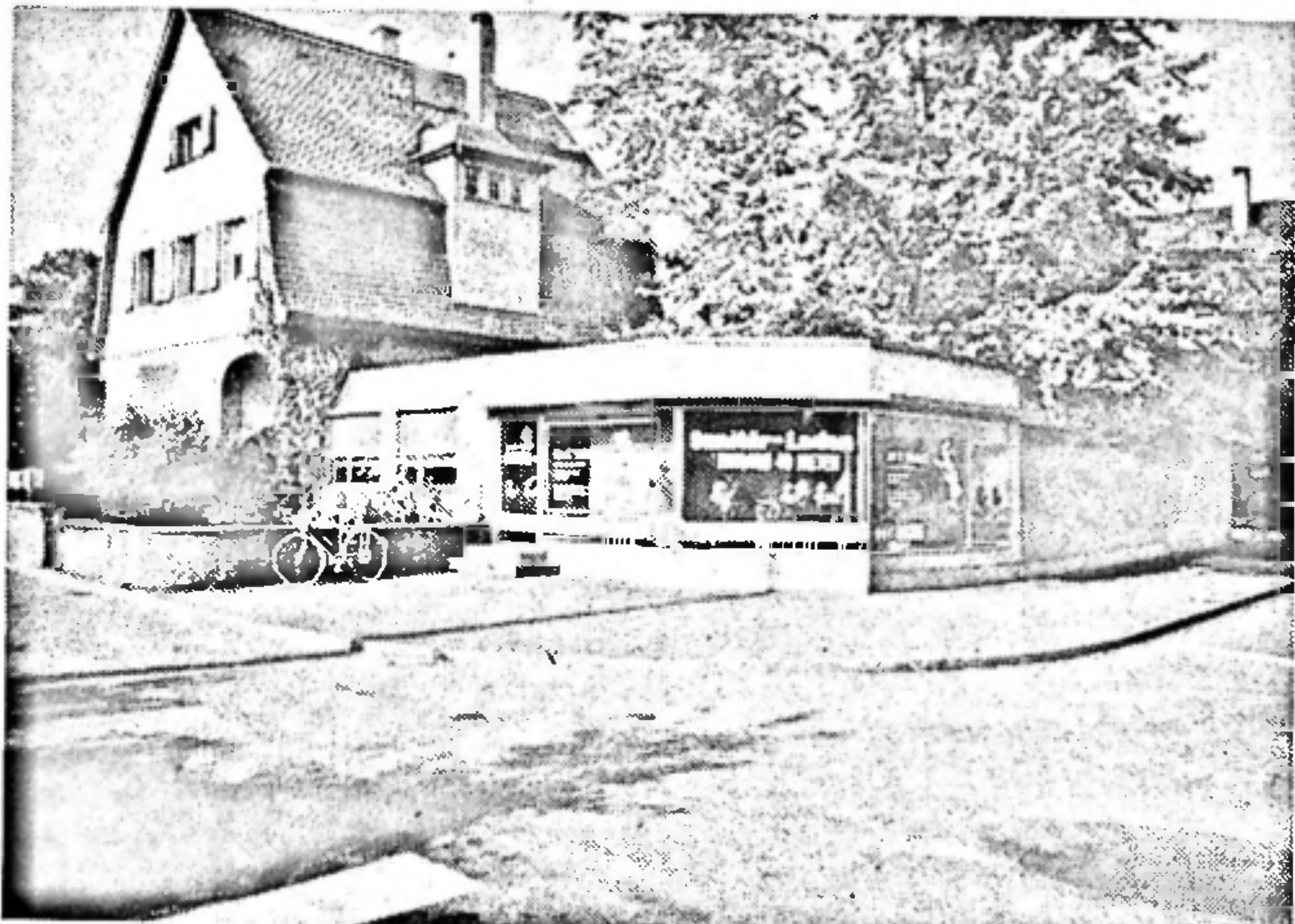
Anstelle des kleinen Ausstellungsraumes entstand der geräumige Sanitär Laden.
