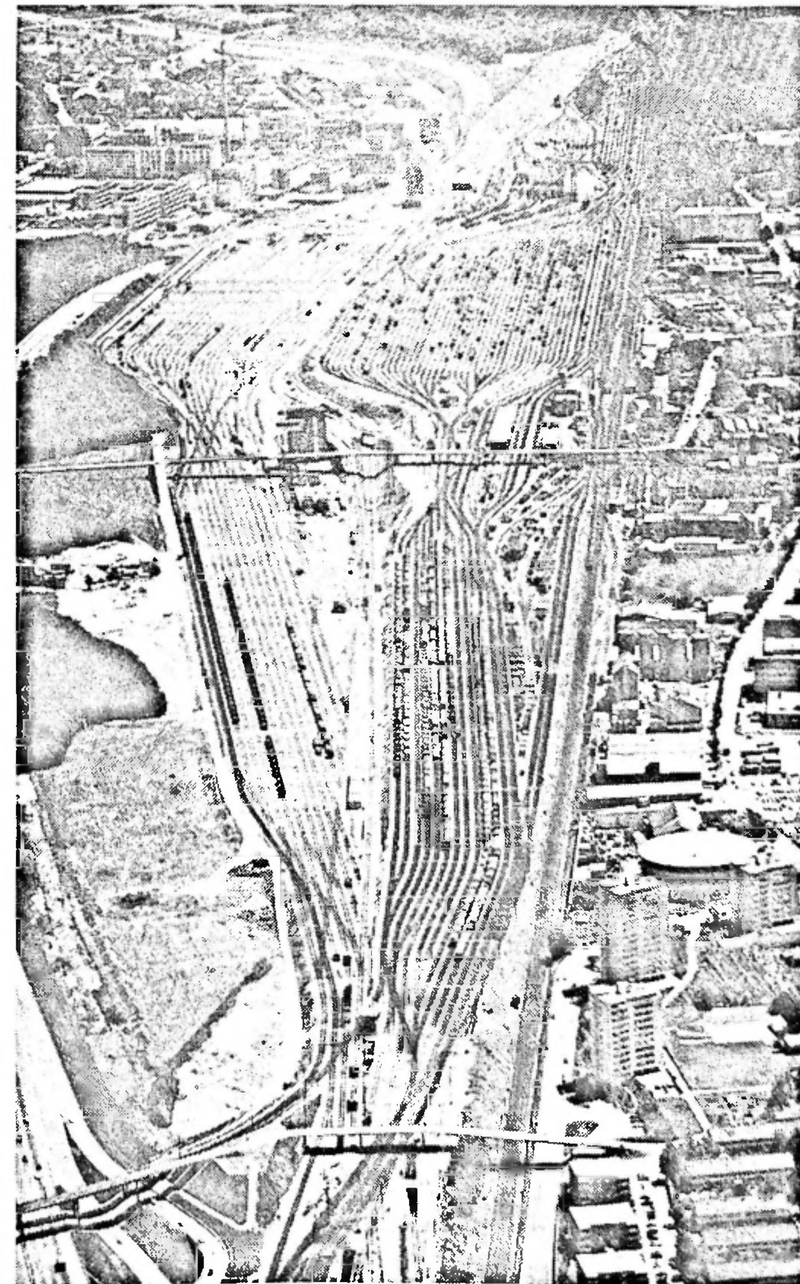
Blick von Westen auf den 4,2 km langen und 400 m breiten Rangierbahnhof im Muttentz Feld.
