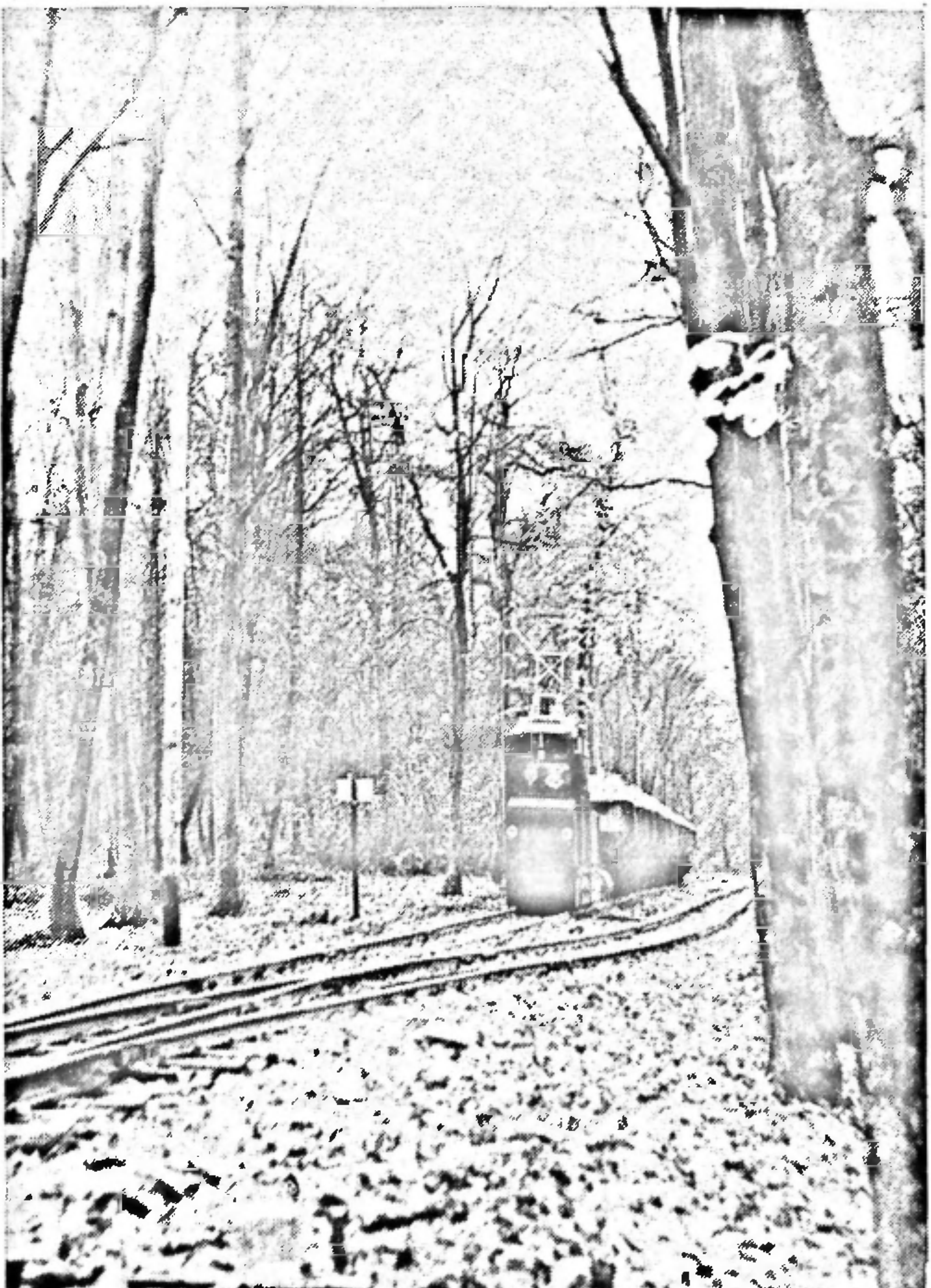
Transportbahn, welche 1951 den Aushub des Kraftwerkes Birsfelden zum Auhafen brachte.
