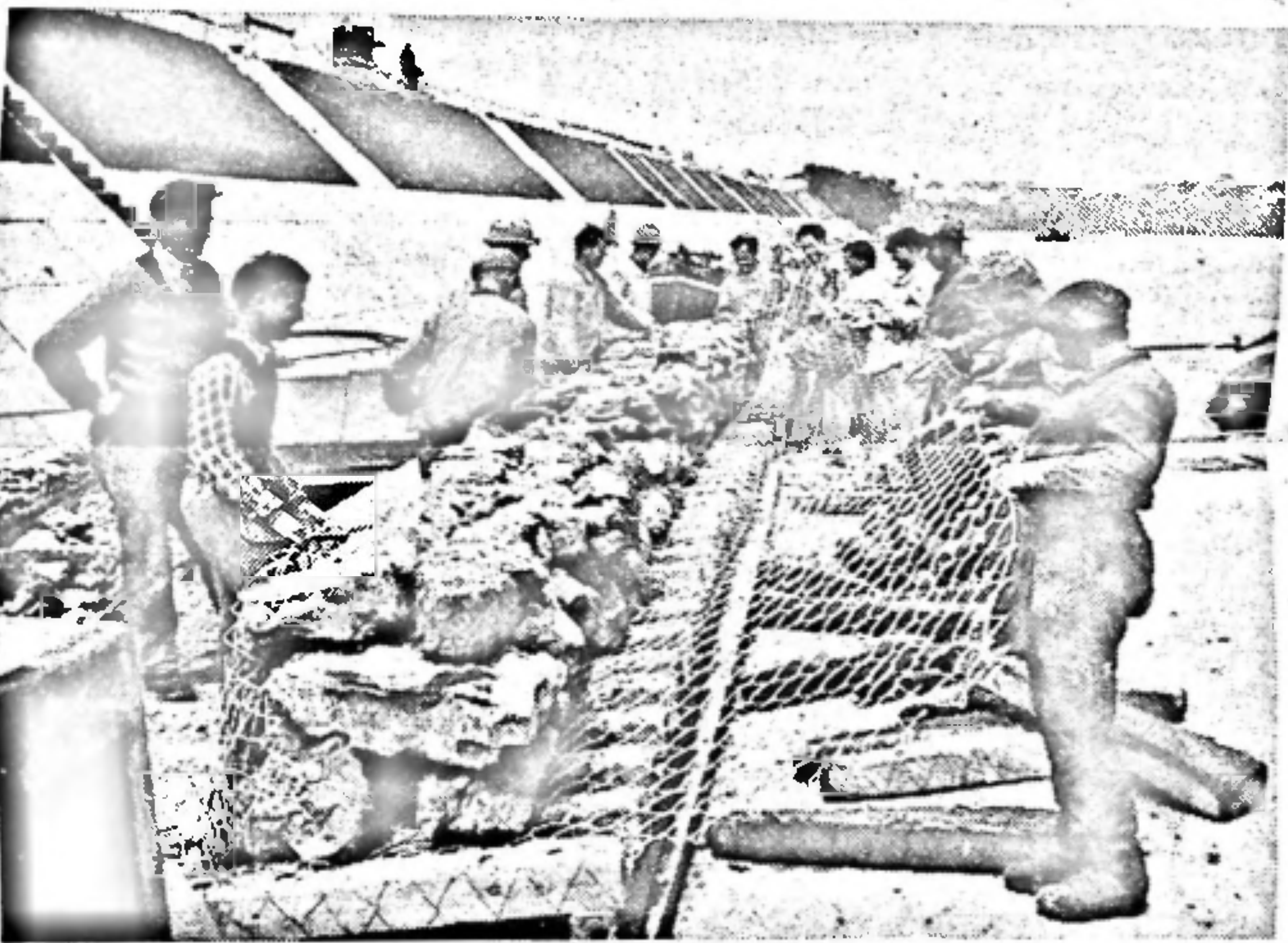
Bau von Steinwalzen zur Ufersicherung. Die Aufnahme entstand am 17. März 1934.
