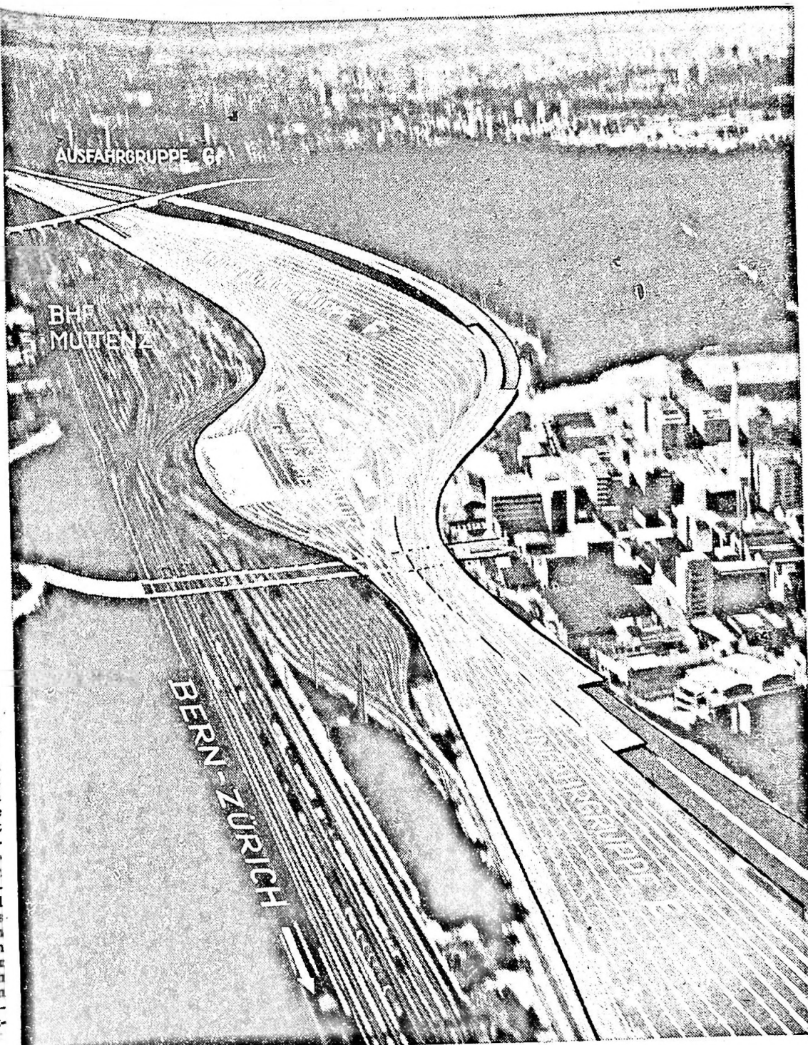
Gesamtübersicht (Flugaufnahme) über das Bahnareal Muttenz. In diese Aufnahme wurde die projektierte Zone des neuen Rangierbahnhofes Muttenz II eingezeichnet. Photo: Kern Film AG, Basel
