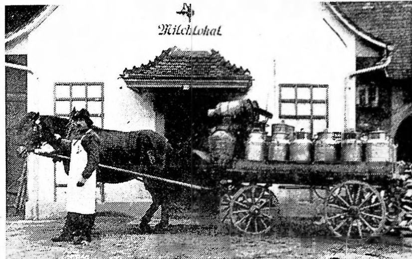
Das erste Milchlokal wurde 1910 erbaut.
