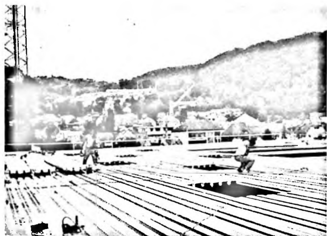
Das Dach der Sport- und Schwimmhalle wird eingedeckt.
