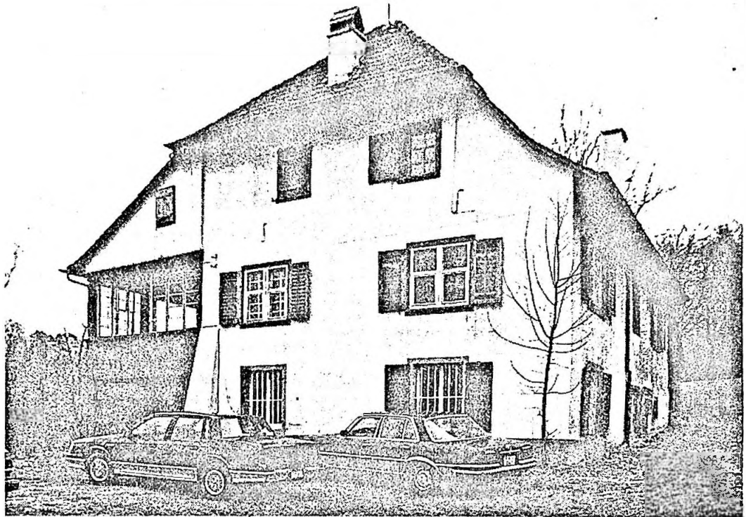
Der renovationsbedürftige Asphof in Münchenstein.
