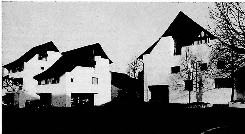
MuttENZ, MittENZA, erbaut 1966–1970.
