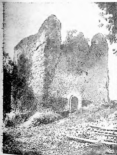
Wartenberg, Mittlere Ruine vor der Renovation
