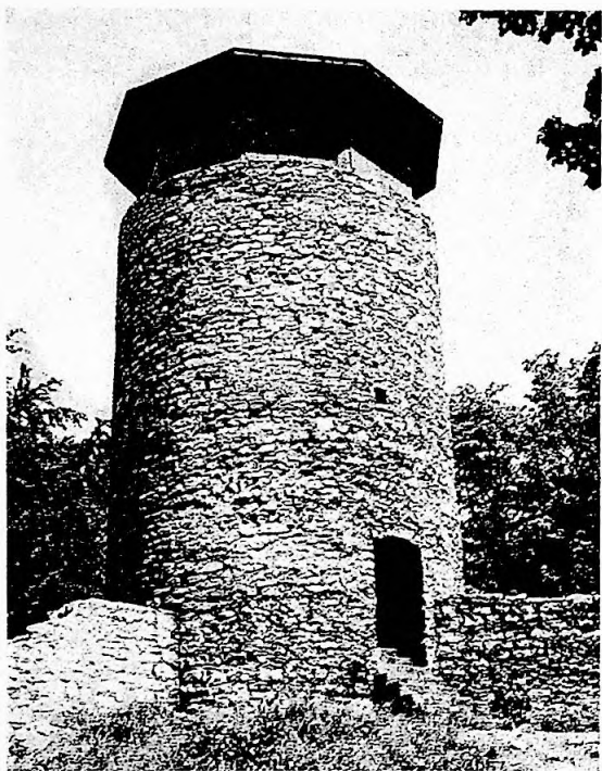
Hinterer Wartenberg, Wehrturm von Süden
