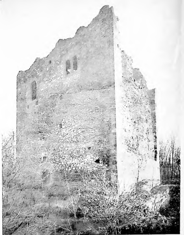
Der Mittlere Wartenberg von Nordwesten, nach der 1934 erfolgten Renovation
