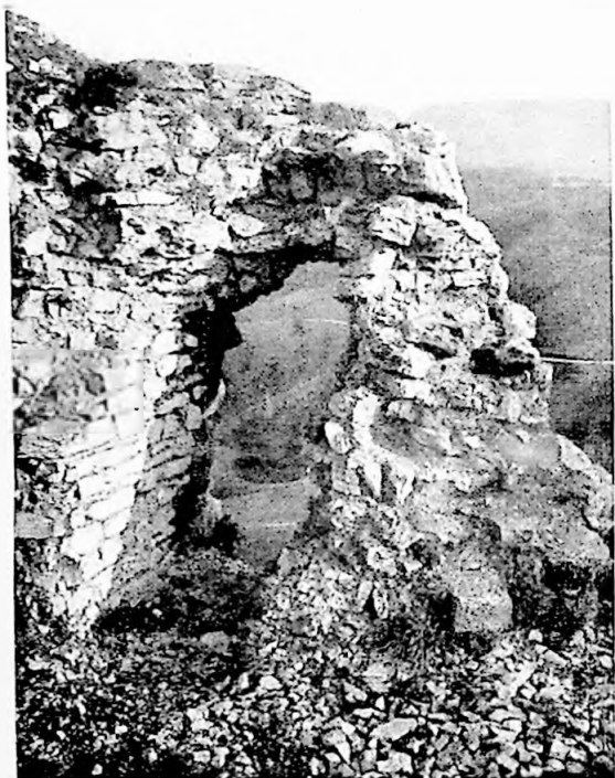
Innenansicht der Fensternische in der südwestlichen Ringmauer des Vorderen Wartenberg. Die Aufnahme wurde unmittelbar vor der im Sommer 1953 erfolgten Restaurierung gemacht und veranschaulicht den zunehmenden Zerfall der Mauerzüge in markantester Weise.
