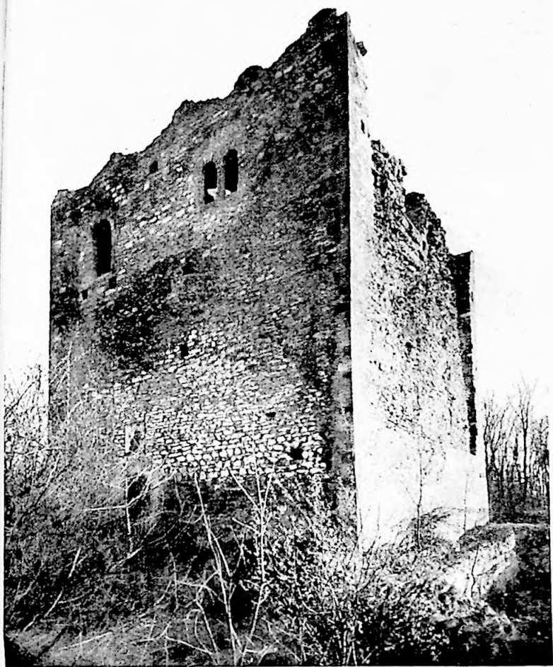
Der Mittlere Wartenberg von Nordwesten. Nach der 1934 erfolgten Renovation.
