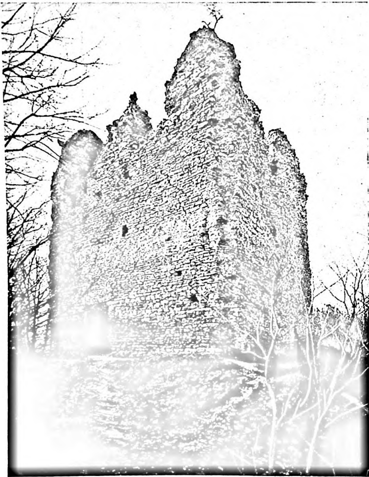
Bild 14: Mittlere Ruine von Nordwesten, vor der 1932/34 erfolgten Restaurierung
