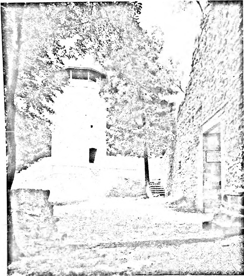
Bild 28: Hintere Ruine nach der Restaurierung, 1956
