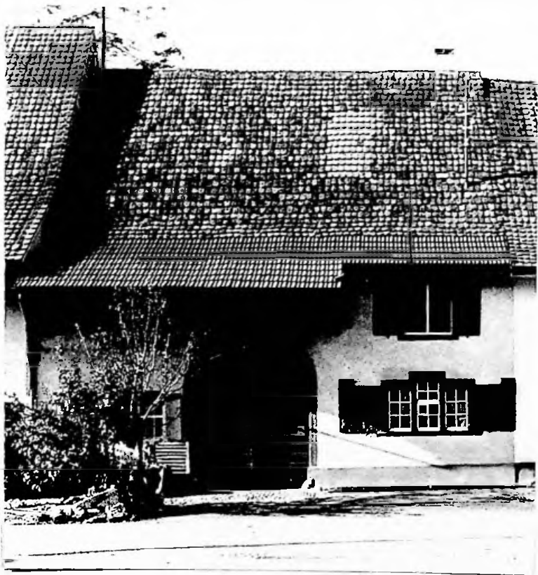
Kuckwenger Bauernhaus - Museum vor der Restauration
