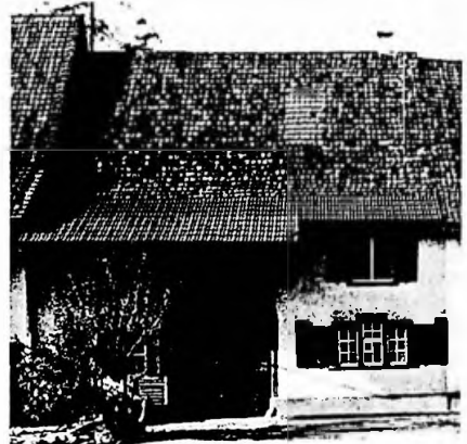
Muttenger Bauernhaus-Museum vor der Restauration.
