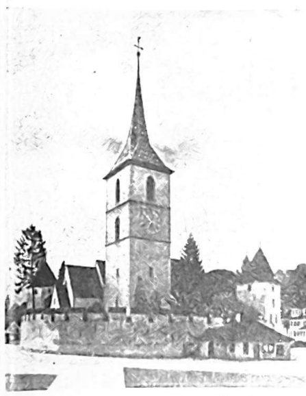
Die Burgkirche St. Arbogast (Photo Lüdlin AG, Liestal)
