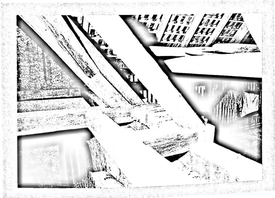
Abb. 17 Dachstock: Auflage der Sparren auf der Mauerpfette
