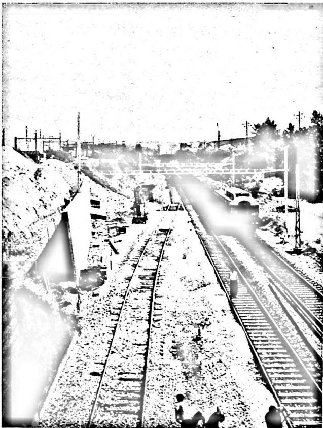
Für den Bau des Widerlagers Süd der Schänzliüberwerfung muß die Stammlinie (Reisezuglinie Basel-Muttenz-Pratteln) auf etwa 400 m verlegt werden; im Bild sichtbar die Vorbereitungen hiezu.
