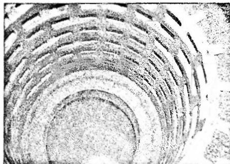
Abb. 5: Rohrbrunnen Auweg im Aufbau, im Caisson aufgenommen. Die Abbildung zeigt die aufgemauerten Filtersteine mit hinterfülltem Filterkies. Der untere, in den Fels abgeteufte Brunnen hat einen engeren Durchmesser als der obere Teil. Photo Max Meyer.
