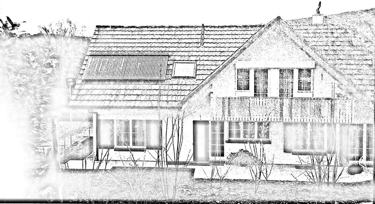
*Vakuum-Röhren-Kollektoren als wenig störendes Element auf dem Dach zur Unterstützung einer konventionellen Heizung*
