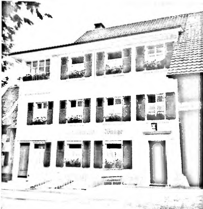
Das Wohnhaus mit Restaurant nach neuer Bemalung.
