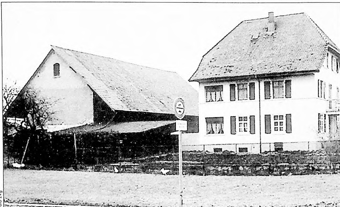
Jakobshof. Die Tage des Muttенzer «Jakobshof» an der Birsfelderstrasse sind gezählt. Bald wird im westlichen Teil von Muttенz ein interessanter Zeuge aus vergangener Zeit verschwinden.
