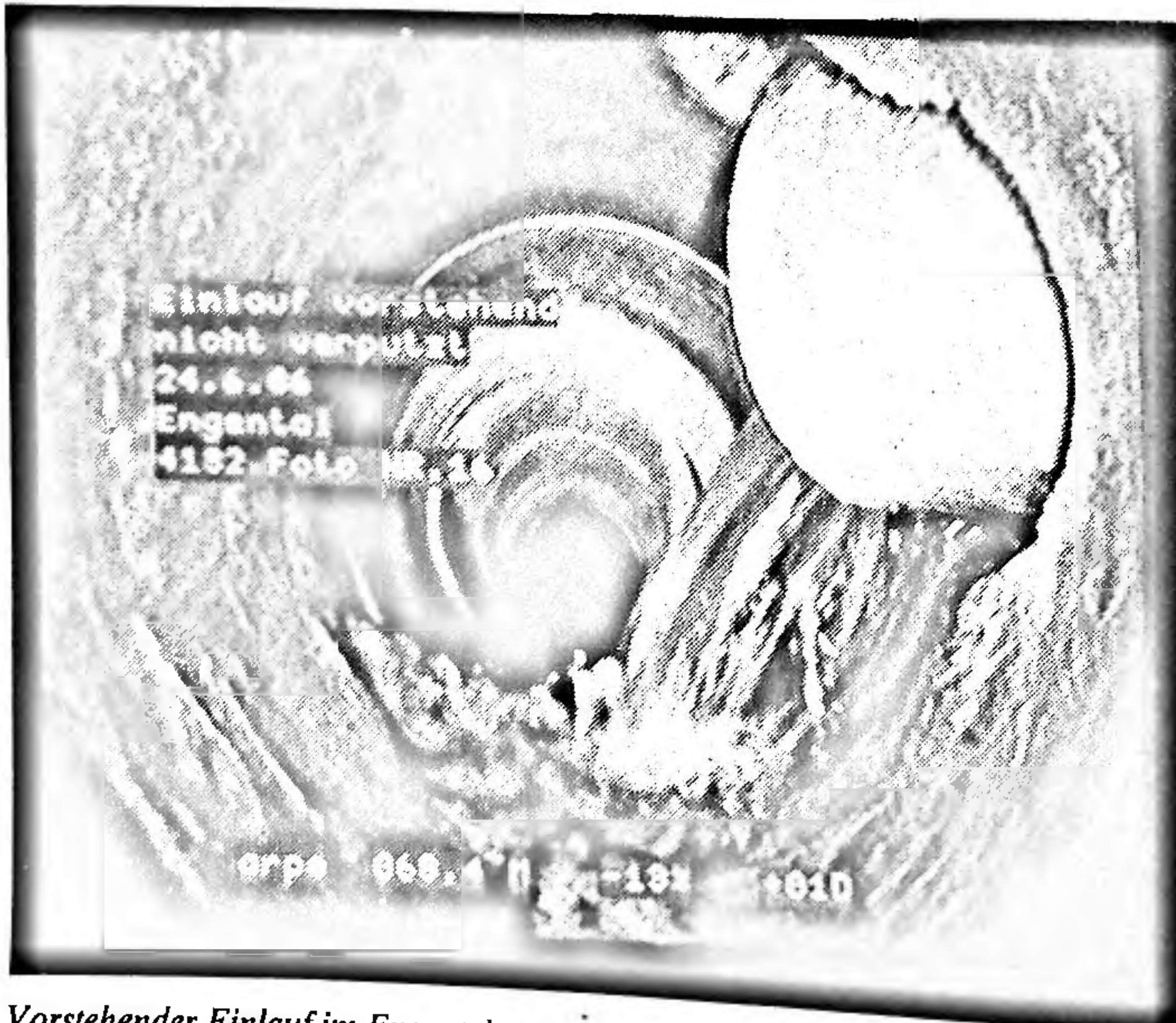
Vorstehender Einlauf im Engental.
