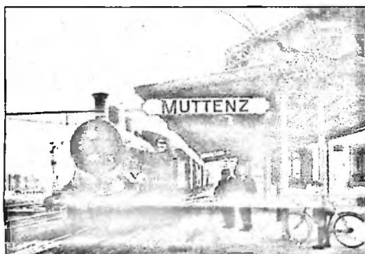
Die Bahnstation Muttenz damals um 1896.
