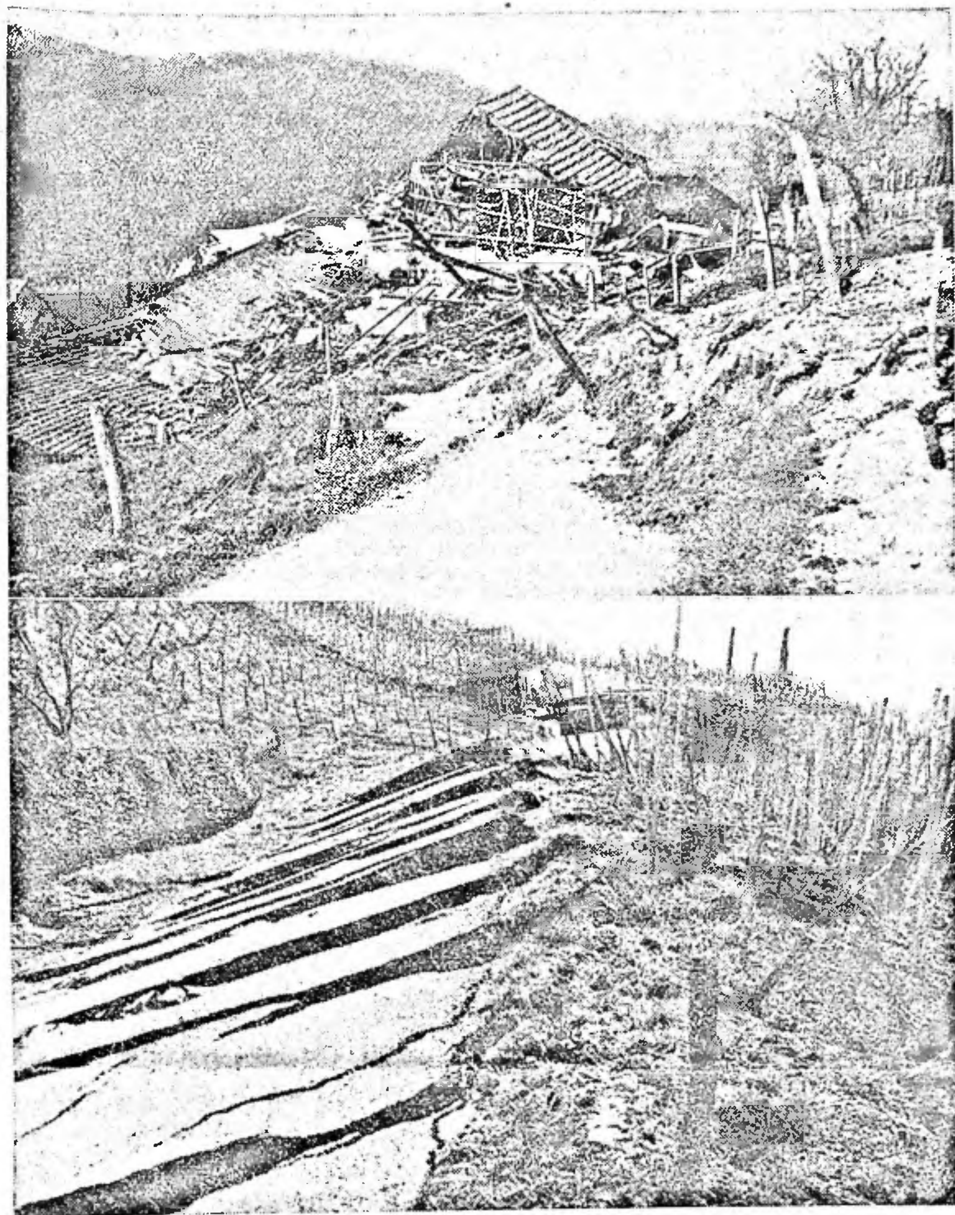
Oben: Die Weinberggasse mit dem eingestürzten Doppelwohnhaus der Familien Honegger und Schenk. Unten: Der erst vor kurzem angelegte Hallenweg.
