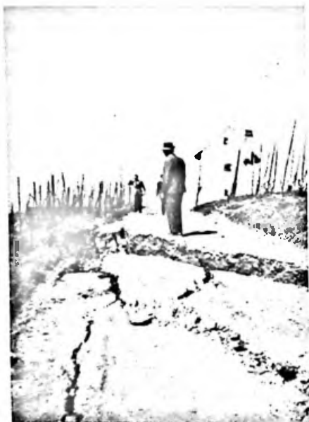
Abbildung 23. Abriss West der mittleren Teilrutschung. Beginnender Abriss der oberen Teilrutschung südöstlich des Bannwarthhauses, Hallenweg und Bannwarthhaus durch die Drehbewegung der oberen Teilrutschung schiefgestellt.
