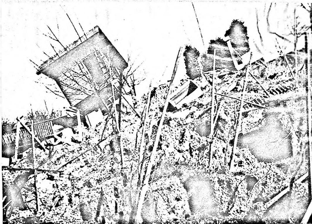
So sieht es im Unglücksgebiet oberhalb von Muttenz aus. Ein aus seinen Fundamenten gehobenes Wochenendhäuschen erinnert an frohe Stunden vor dem gänzlich unerwarteten Naturereignis.
