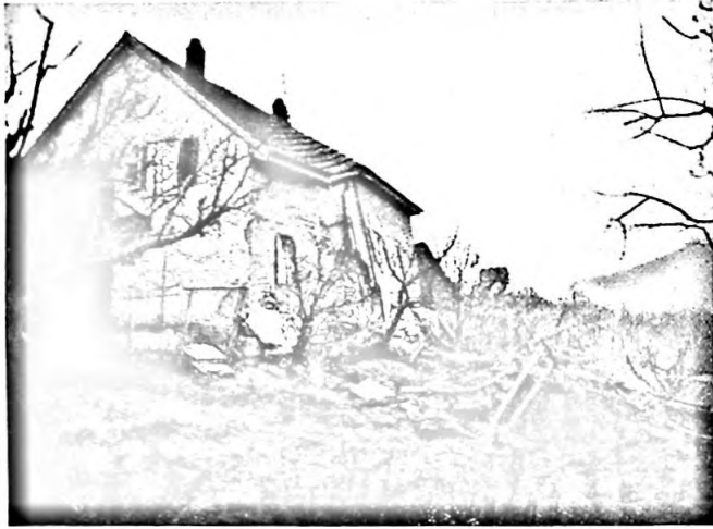
Abbildung 35. Untere Teilrutschung. Doppelwohnhaus und Wulst der unteren Teilrutschung nach Beginn der Bewegung. Photo BERTOLF, 8. April 1952, etwa 6 Uhr
