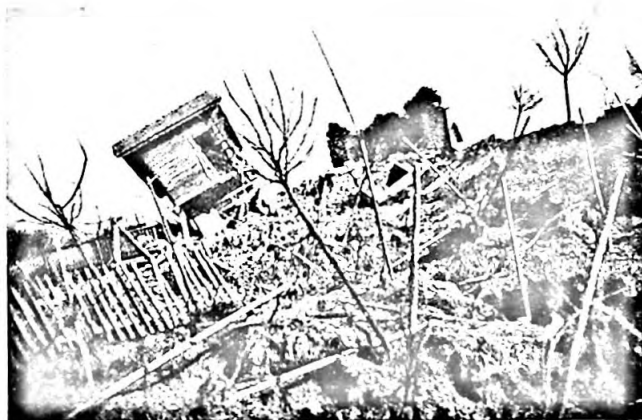
Abbildung 22. Abriss West der mittleren Teilrutschung. Durch mittlere Teilrutschung abgerissene Wulst der oberen Teilrutschung mit talwärts schiefgestelltem Gartenhaus. Blick von Südosten. Photo BERTOLF, Basel, 8. April 1952, vormittags
