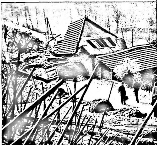
Von der Höhe des Wartenbergs wälzen sich die Erdmassen, alles unter sich begrabend, gegen ein Doppelwohnhaus. Wenige Stunden nach unserer Aufnahme war auch von diesem nichts mehr zu sehen.
