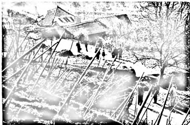
Abbildung 33. Untere Teilrutschung. Verschiebungsspalte zwischen «Doppelwohnhaus»-Scholle einerseits und «Bunker»-Scholle bzw. Vorgelände andererseits an der Weinbagstrasse. Hinten: «Doppelwohnhaus»-Scholle mit Doppelwohnhaus. Vorne links: «Bunker»-Scholle. Vorne rechts: Vorgelände. Photo DIERKS, 8. April 1952, etwa 11 Uhr
