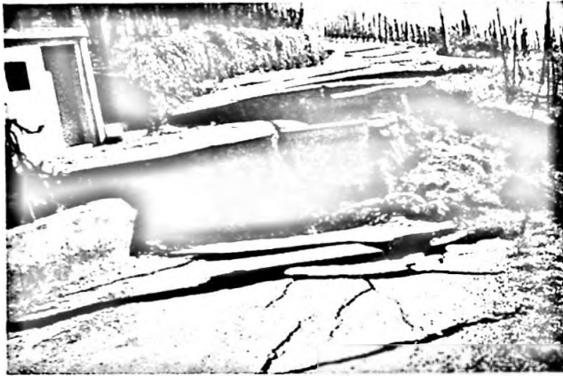
Abbildung 28. Abriss Ost der mittleren Teilrutschung. Südöstliche, seitliche Abriss- und Verschiebungsspalte bei Beginn der Rutschung. Gerätehäuschen (links auf dem Bilde) noch nicht zerstört. Photo DIERKS, 8. April 1952, vormittags
