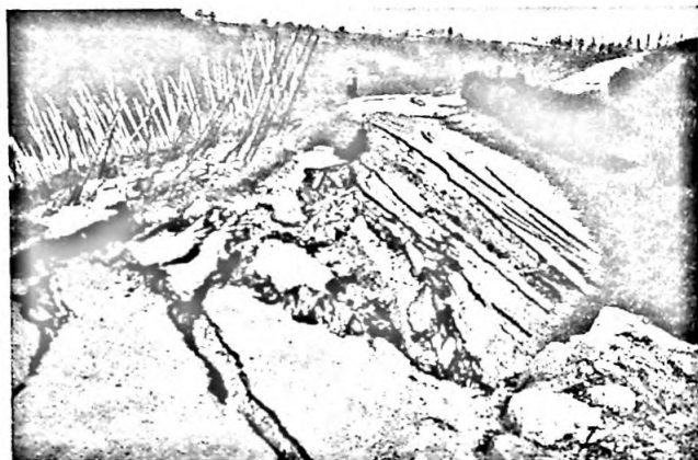
Abbildung 25. Mittlere Teilrutschung. Durch Drehbewegung der abrutschenden Schollen hangwärts geneigte Schauenburgerstrasse östlich der Grube. Blick gegen Westen. Photo DIERKS, Basel, 8. April 1952, vormittags
