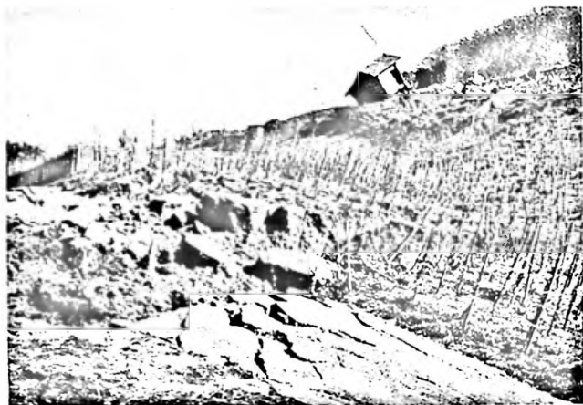
Abbildung 26. Mittlere Teilrutschung. Durch Drehbewegung gegen Hang geneigte Rutschschollen am Neusetzweg. Verschiebungsspalte in der Fortsetzung des seitlichen Abrissrandes der unteren Teilrutschung (vordere Scholle später von unterer Teilrutschung erfasst!). – Oben: Durch Abriss der mittleren Teilrutschung zerbrochener Wulst der oberen Teilrutschung mit schiefgestelltem Gartenhaus.
