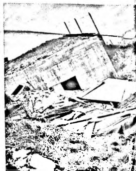
Der schwere Bunker, der dem Erd- druck einwandfrei standhielt, verlor seinen Untergrund, rutschte 60 Me- ter talwärts und legte sich schließ- lich auf die Seite.
