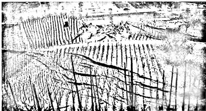
Abbildung 21. Obere Teilrutschung. Blick von Burghaldenstrasse auf Rutschung: Klaffende Spalten zwischen Abriss der oberen Teilrutschung und Hallenweg. Abgesunkene Scholle oberhalb Grube mit in der Gleitrichtung verlaufenden Brüchen. Photo des Verf. 10. April 1952
