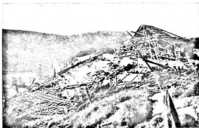
Abbildung 36. Untere Teilrutschung. Doppelwohnhaus und Weinhagstrasse von Osten. Verschiebung der Weinhagstrasse durch Verschiebungskluft zwischen «Doppelwohnhaus»-Scholle und «Depressions»-Scholle. Trümmer des Doppelwohnhauses infolge Überschiebung des Wulstes gegen die Talseite gekippt.
