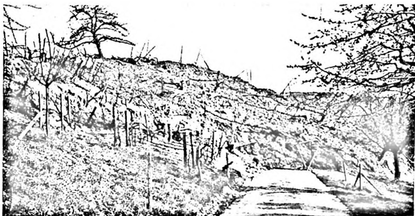
Abbildung 34. Untere Teilrutschung. Überschiebung des Wulstes der «Bunker»-Scholle auf die Weinhagstrasse. Photo Polizeikommando Baselland, 9. April 1952, nachmittags
