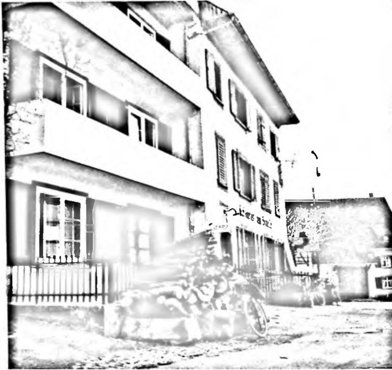
*Ein drastisches Beispiel von der häßlichen Wirkung der Balkone mit massiven Betonbrüstungen. Sie wirken wie herausgezogene Schubläden und zerstören jede ruhige Fassadenwirkung. Ein leichtes Eisen- oder Holzgeländer würde den gleichen Dienst tun, sähe aber viel besser aus. Monstrueuses baignoires, les balcons de béton avilissent des façades que le bois, le fer forgé auraient su respecter.*
