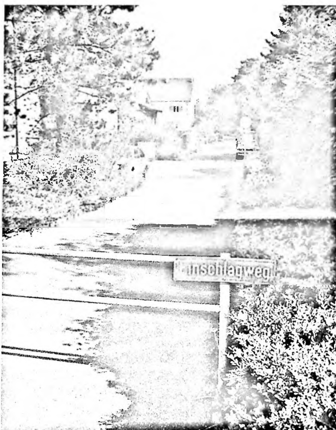
Ischläge wird heute oft, um den Fussgänger vor dem rollenden Verkehr zu schützen, wie etwa beim «Ischlagwäg» in Reinach.
