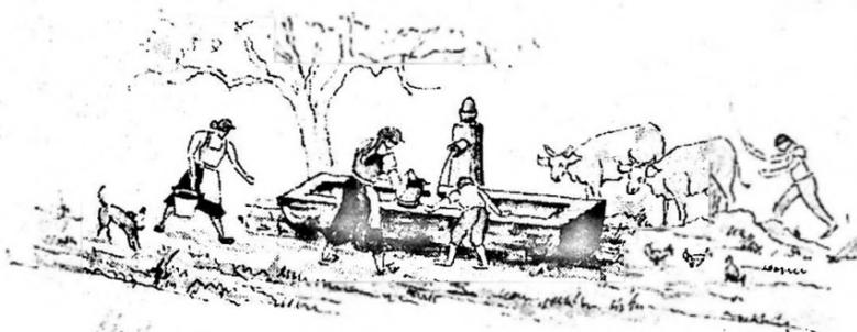
Um das Quellwasser in die Nähe der Häuser zu leiten benützte man ursprünglich Tüchel. Das sind röhrenartig ausgehöhlte Teile von Baum-Stämmen. Diese Tüchel wurden aneinander gereiht, in die Erde verlegt und bis zu den Brunnen geführt. Die ersten Brunnen bestanden nur aus dem Trog, der aus einem dicken Eichenstamm geformt war. Das Ende der Wasserleitung, ein Holzkänel wurde auf den Trogrand verlegt von wo das Wasser in den Trog plätscherte.
