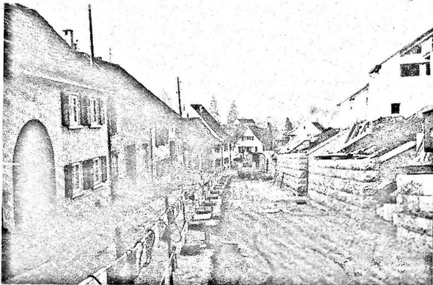
*Unsere Aufnahme zeigt die gegen den Hang verschobene Gempengasse mit der neuen Stützmauer. Durch den gewonnenen Raum kann vor der südlichen Häuserzeile ein Trottoir angelegt werden. Die Bauarbeiten werden noch bis in den Herbst andauern.*
