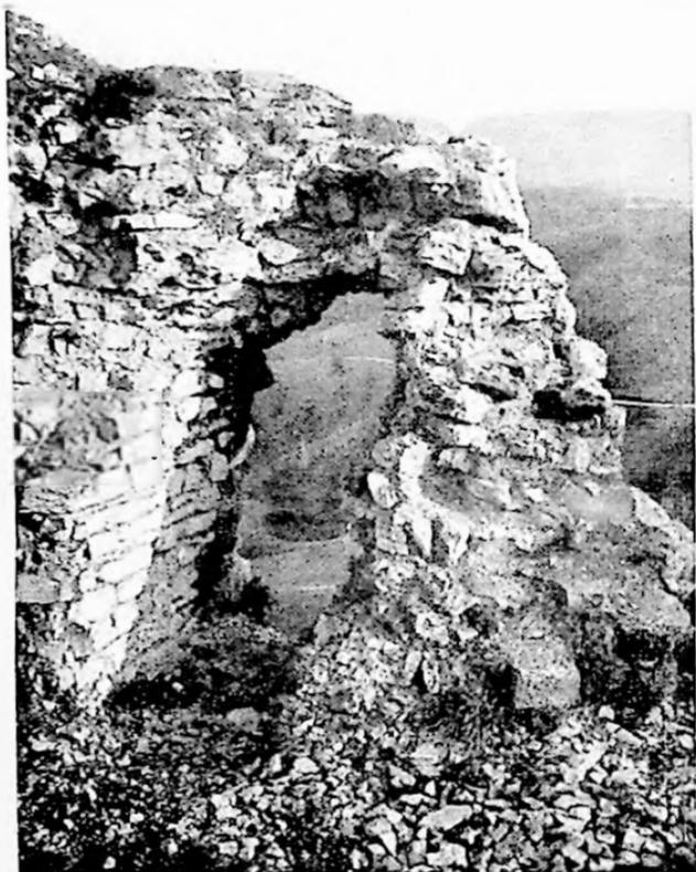
Innenansicht der Fensternische in der südwestlichen Ringmauer des Vorderen Wartenberg. Die Aufnahme wurde unmittelbar vor der im Sommer 1953 erfolgten Restaurierung gemacht und veranschaulicht den zunehmenden Zerfall der Mauerzüge in markantester Weise.
