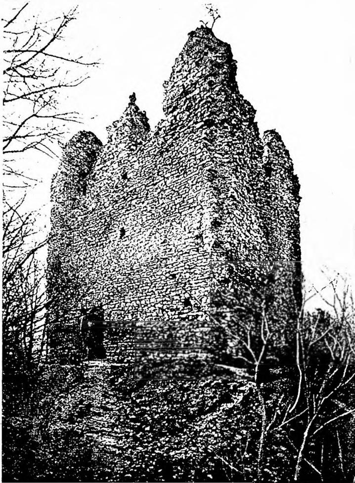
Die mittlere Burg auf dem Wartenberg 1907. Photographie von K. Rathe-Fehlmann, Basel. Schon auf dieser Aufnahme sind die Balkenlöcher der steilen Treppe zum (erst 1934 anhand von vorgefundenen Teilstücken rekonstruierten) romanischen Zugang im zweiten Turmgeschoss klar zu erkennen.
