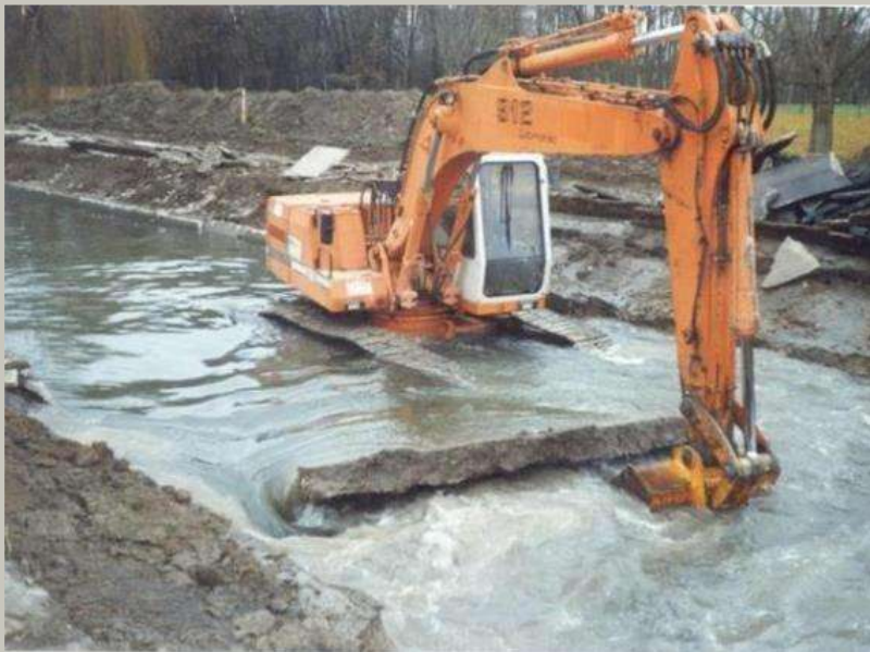
Retrait de béton d'Il de l'Orge à Morsang sur Orge en 1997 ( l'Orge est encore bétonnée à Savigny sur Orge )
