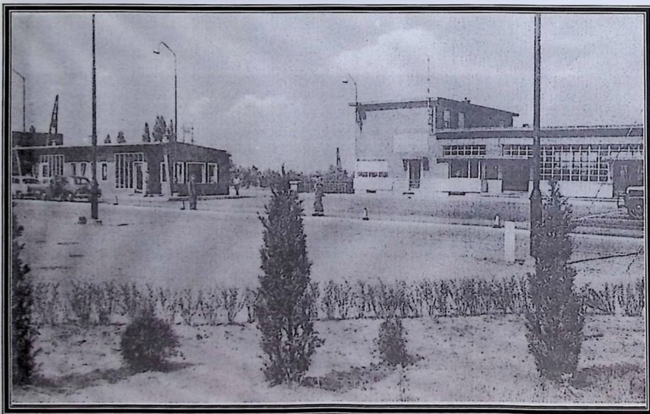
DIT IS AL HET VERNIEUWDE TOLKANTOOR AAN DE GRENS.
